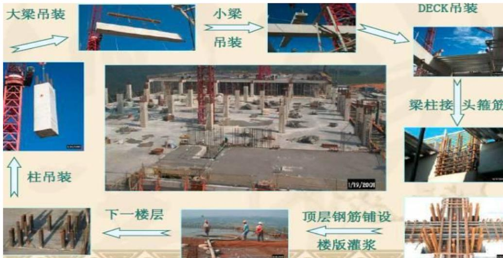
为了增加装配式构件和现浇层之间的连接，确保结构的可靠性和安全性，装配式构件表面都留有键槽或进行毛糙处理。装配式构件之间可以有多种连接方式，目前楼板通常采用 7+8 的形式（70mm 厚预制楼板+80mm 厚现浇层）。以主次梁连接节点为例，展示装配式构件之间连接种处理方式的多样性：
